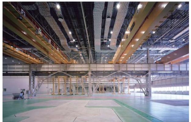
1.5年の受注残を抱える機械製作メーカーの製造・組み立てライン 16,000m<sup>2</sup>の増築工事を、設計から稼働まで10ヶ月強という短工期で実現した。凹凸の激しい岩盤を埋め立てて造成された工業団地の地業や、数十本の大型クレーンを配した構造体の、並外れた高さ・広さもさることながら、床精度3mで5mm以内という要求に応えるべく様々な施工上の工夫がなされた。
