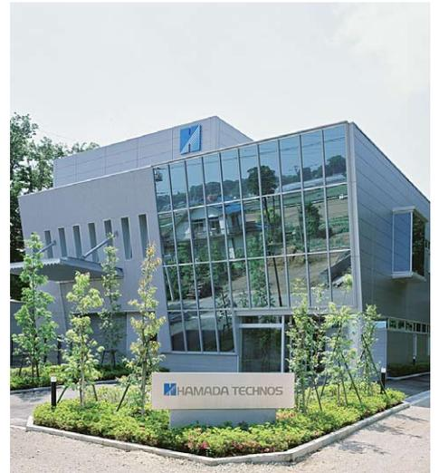
半導体部品の加工組立工場で、クリーンルーム性能はクラス 5,000 と 10,000。生産設備の更新に対応するため、フレキシブルな大スパン 2 層の鉄骨造とした。また、十分な天井ふところを確保し、歩行できる複合パネルを採用、変電設備は変更対応が容易なプラグイン方式としている。空調設備は冷温水同時取り出し方式空冷チラーによる温湿度制御、外壁と屋根は鋼板断熱パネル使用により省エネルギー化を図った。外観はシャープな形状として電子部品工場らしさを表現した。
