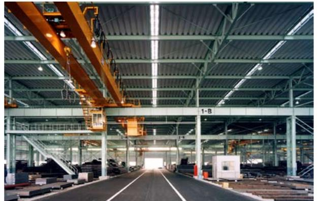
老舗鉄鋼商社である明鋼材の最大鉄鋼集積地、弥富センターの増築である。鋼材の入出荷ルートやストックヤードについては、10年前の新築時に計画していた増築レイアウト通りに建設された。就業人員増に伴い、本部棟にあった食堂・更衣・休養室などの厚生ゾーンは、物流の妨げにならぬよう通路上屋の上部に新設した。海が近く、内外装材や使用金属類と設備機器などは塩害に強い材料を選定した。
