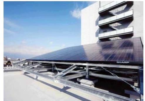
地球温暖化や環境に配慮した建物であり、太陽光発電システムと壁面緑化の両方を導入した。屋上に設置した太陽電池パネルは最大7.5kwの発電量があり、建物内の照明用電力などを賄っている。北側を除く三面の外壁に取り付けた植栽パネルによる壁面緑化は、壁面温度の上昇を抑えて空調負荷を軽減する。構造設計では建築基準法に定められた地震力の1.25倍への割増を行い、大地震後も機能・生活維持が可能な耐震性能を有した建物とすることで、震災時の支局としての情報発信機能を確保している。
