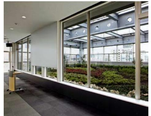
透明感のある清楚なカーテンウォールと1層毎に設けた小庇のアクセントにより、飽きのこないシンプルな外装デザインとしている。事務室はスパン約15mの無柱空間とし、室内レイアウトの自由度を高めている。足元のホッパーからの給気し、ロールブラインドと外部サッシ間を流れ、サッシ上部から排気する自然換気システムを採用することで、ペリメータ部分の熱負荷低減を図っている。7、8階のテラス部分は緑化し、建物への熱負荷低減と共に癒しの空間を提供している。
