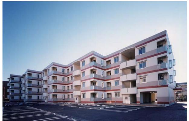
建物配置を雁行させ日影の影響を緩和するとともに、居室の2方向採光と換気が居住性を高めている。バルコニーの手摺腰壁には指向性ガラスブロックを使用し、室内の奥まで光を取り込む。南側道路面には遊歩道、西側角地に緑に囲まれたポケットパーク、敷地内の日当たりの良い場所には地域に開放したコミュニティスペースを設けた。
